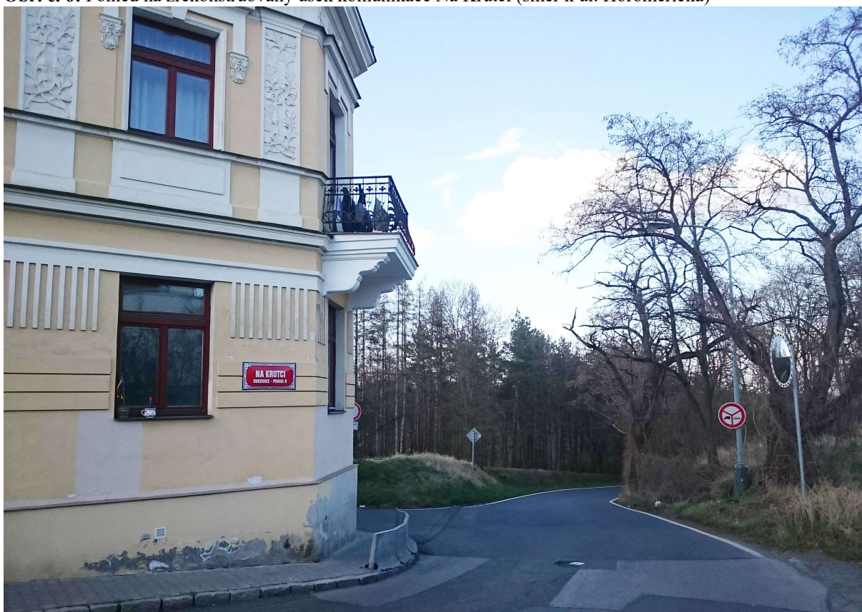
Obr. č. 6: Pohled na zrekonstruovaný úsek komunikace Na Krutci (směr k ul. Horoměřická)
